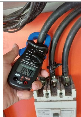
Foto 15 – Medição de corrente na fase A – entrada do quadro, maior corrente medida.
