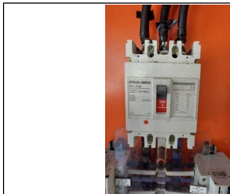
Foto 14 – Disjuntor geral do quadro de distribuição de ar cond.
